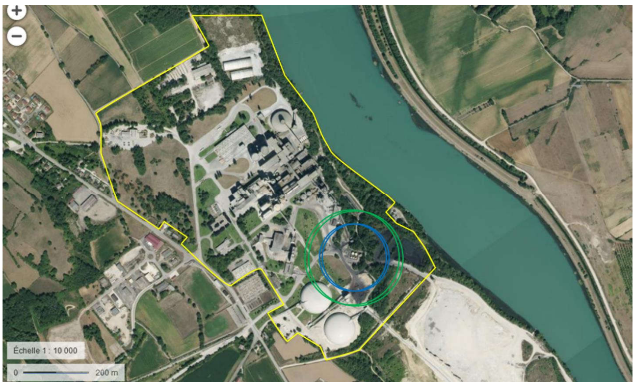
Figure 35 : pressurisation des bacs T5 et T6
